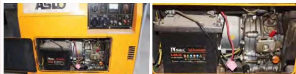
Gerador Aslo Silencioso 5 KVA: 85.000,00 ECV
